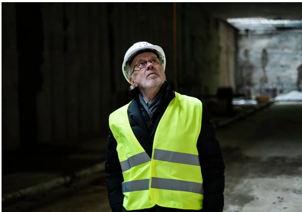
Iso Senn, Verwaltungsrat der Senn Resources AG, auf einem Rundgang durch die Baustelle für das Parkhaus UG25.
